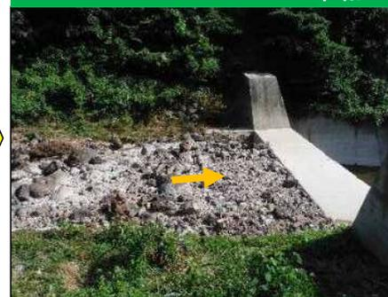
砂防堰堤による土砂捕捉
