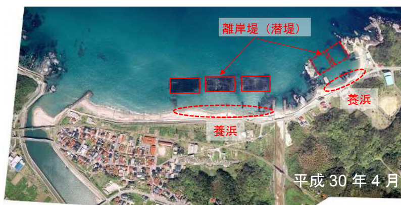
写真－10 (三隅港海岸) 侵食対策
