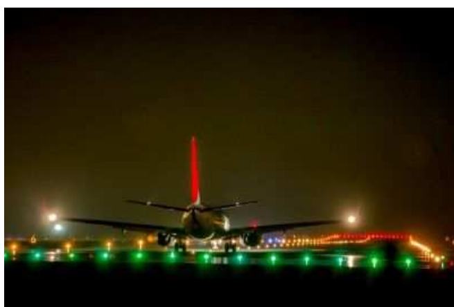
写真一 2 航空灯火点灯状況(出雲空港)
