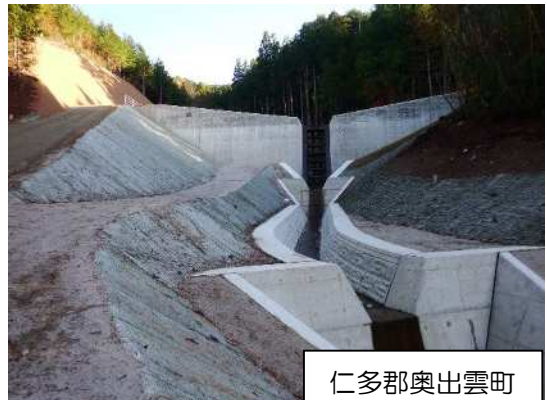
写真－2 砂防堰堤と流路工
