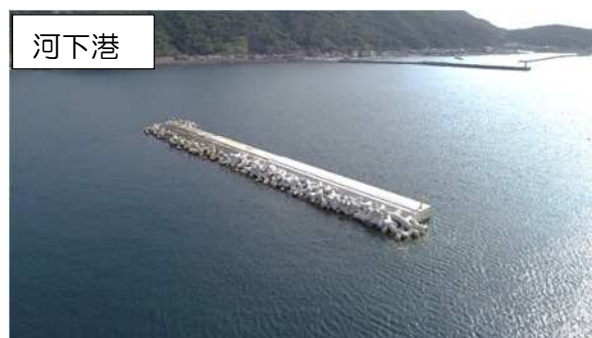
写真－6 沖防波堤の整備
