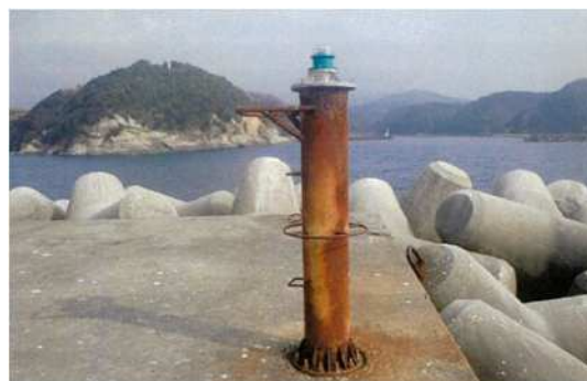
写真－１６ 小規模な施設修繕
