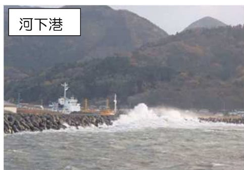
写真－5 海上が荒れた際の岸壁状況
