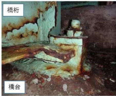
〔支承〕 平成 26 年点検
