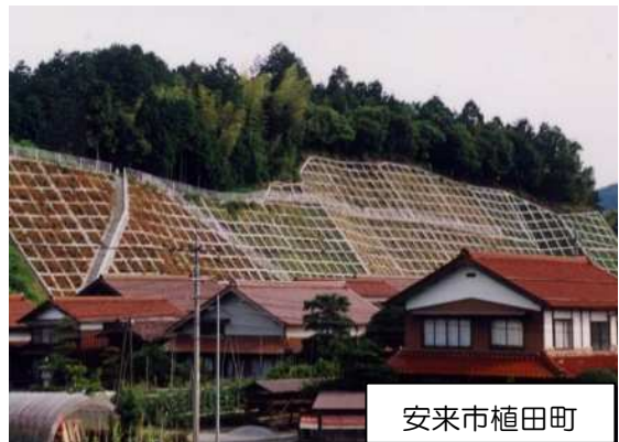
写真－4 斜面对策工（法枠工）
