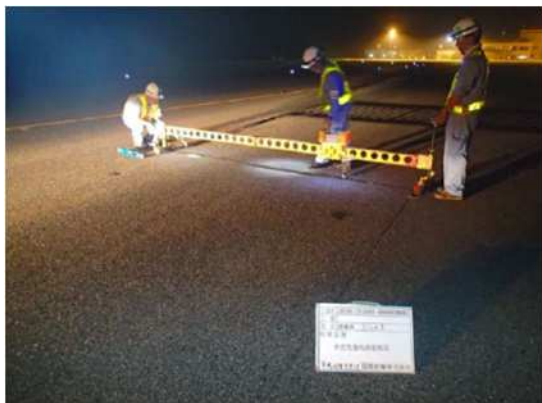
写真－4 滑走路定期点検状況
