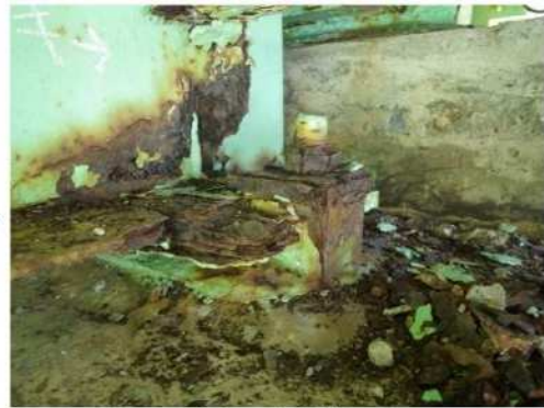
令和元年点検
