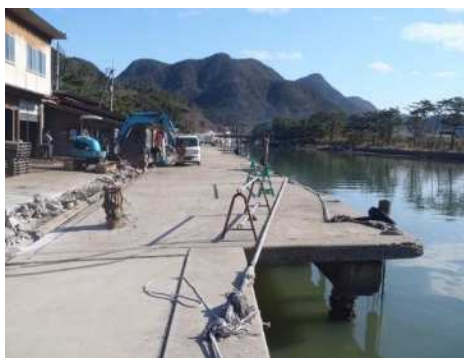
写真－１１ 健全な状態の栈橋
