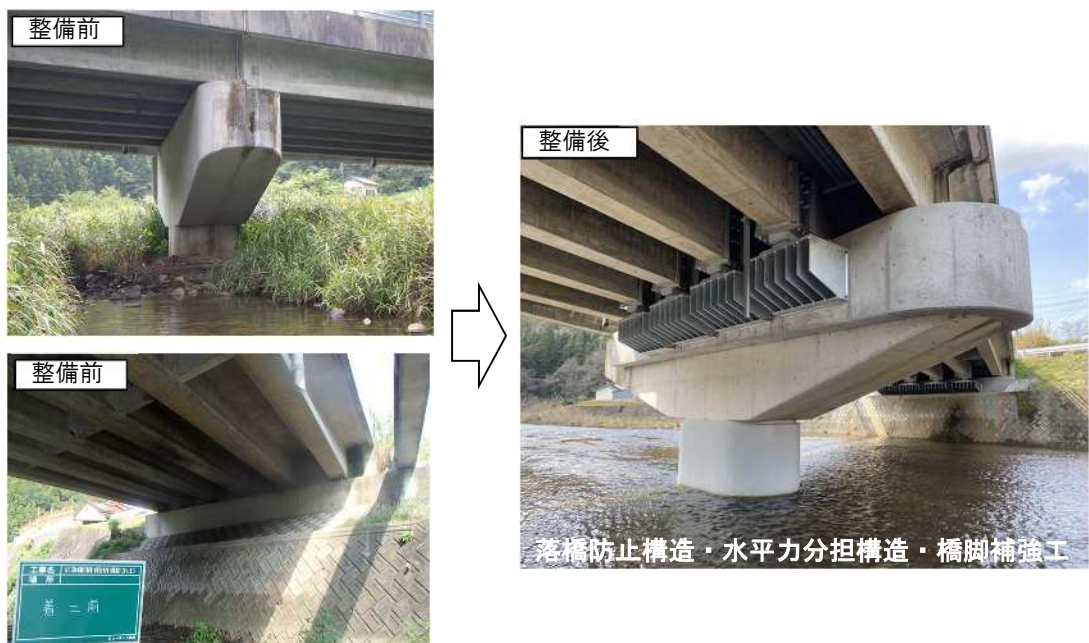
模原橋 (主) 三瓶山公園線 (大田市大田町)
