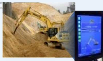
3Dデータを利用した機械施工
