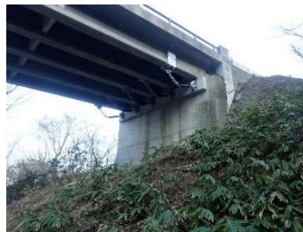
落橋防止構造
