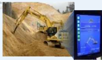
3Dデータを利用した機械施工
