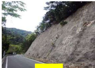
道路の落石対策
