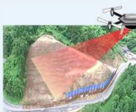
ドローンによる3D測量
