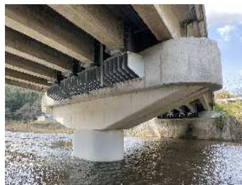
水平力分担構造
