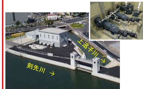
上追子川排水機場（R3.9完成）
