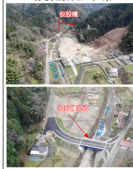
現地状況(令和7年4月)
