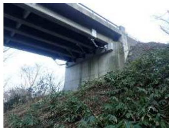
落橋防止構造
