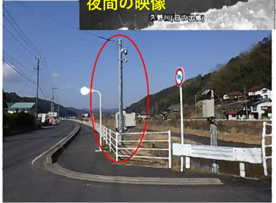
整備事例 久野川（日の出橋）
