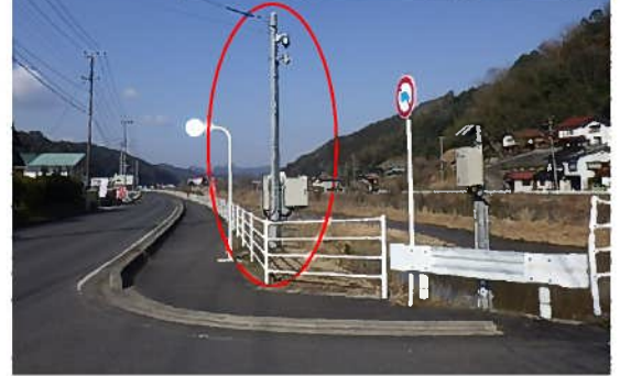
整備事例 久野川（日の出橋）
