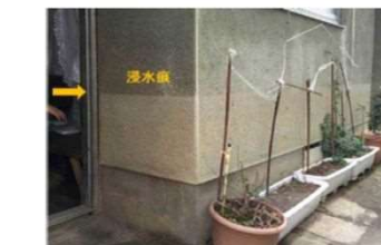
家屋等の浸水痕跡
