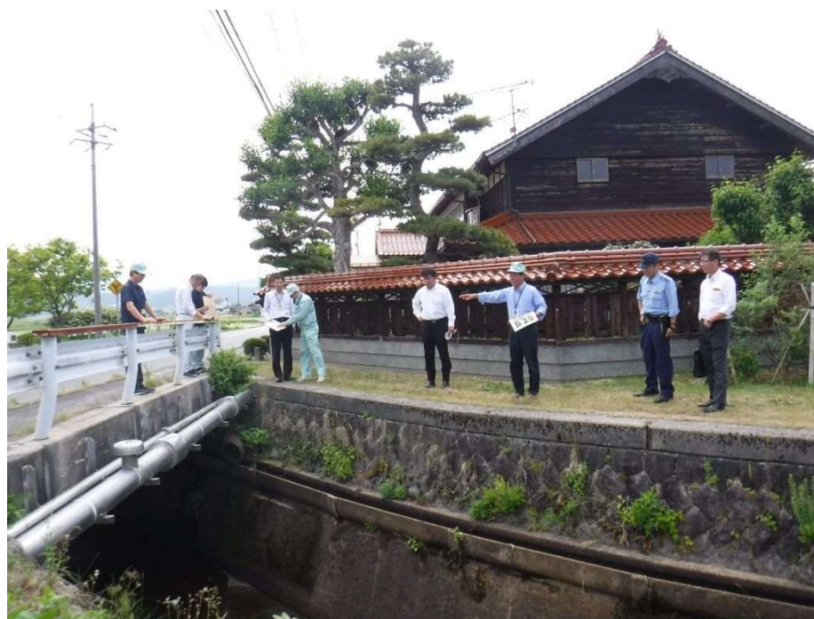
共同点検の状況
