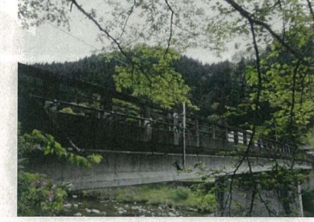
橋の高欄に回転灯が設置されている
