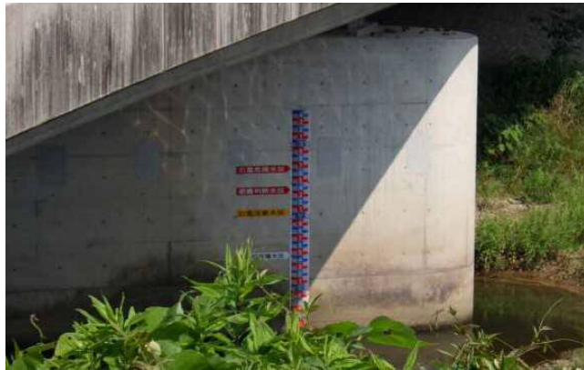
神納橋(八雲町)量水標確認
