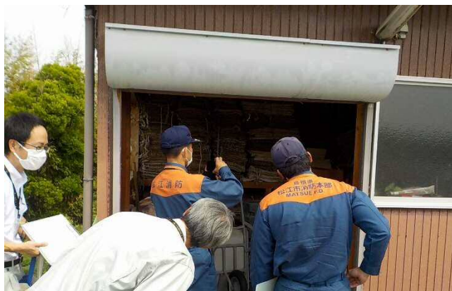
水防倉庫資材の保管状況確認
