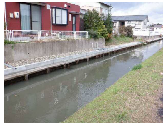
R4 嵩上げ状況
