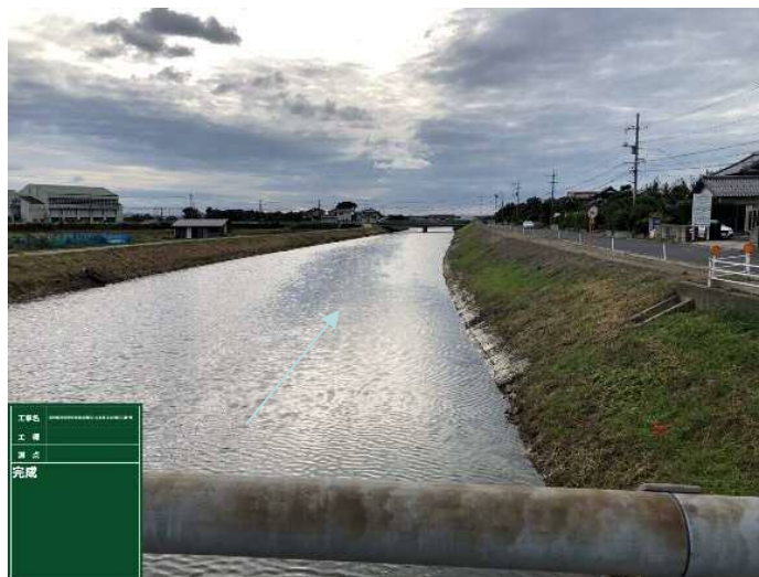
令和4年度 整備状況(寺田橋から下流)
