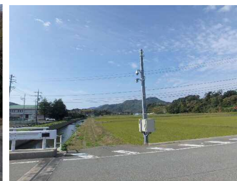
諏訪川(芦田橋)
