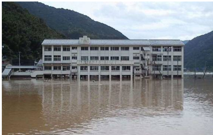
平成26年8月 避難所2階の浸水 (徳島県)
