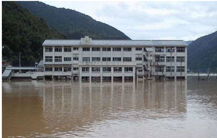
平成26年8月 避難所2階の浸水 (徳島県)
