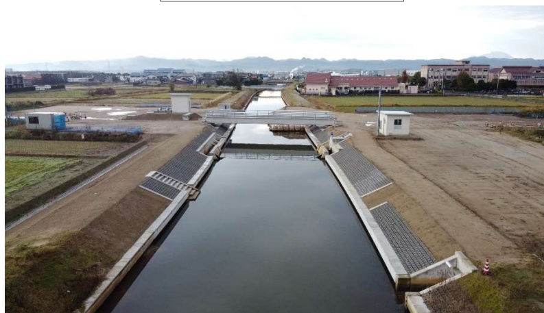
牛頭川 中橋付近整備状況
