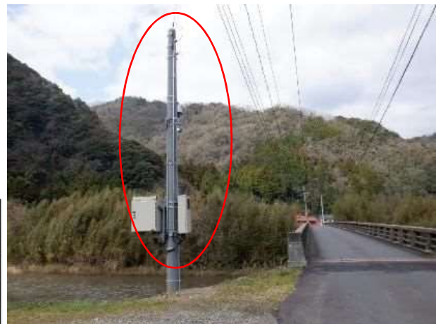
整備事例〔神戸川（木村橋）〕
