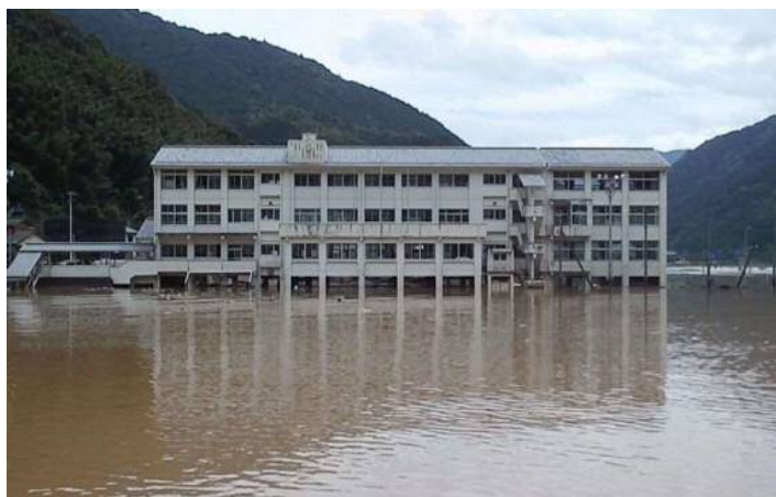
平成26年8月 避難所2階の浸水 (徳島県)
