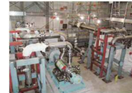
低圧原子炉代替注水ポンプ
