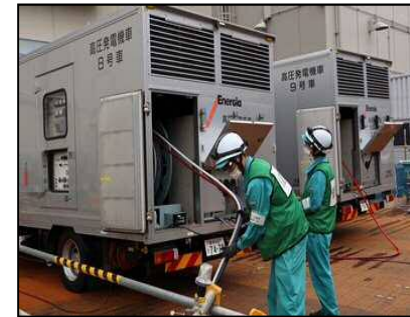
高圧発電機車を用いた現場訓練
