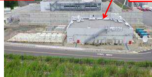
緊急時対策所
