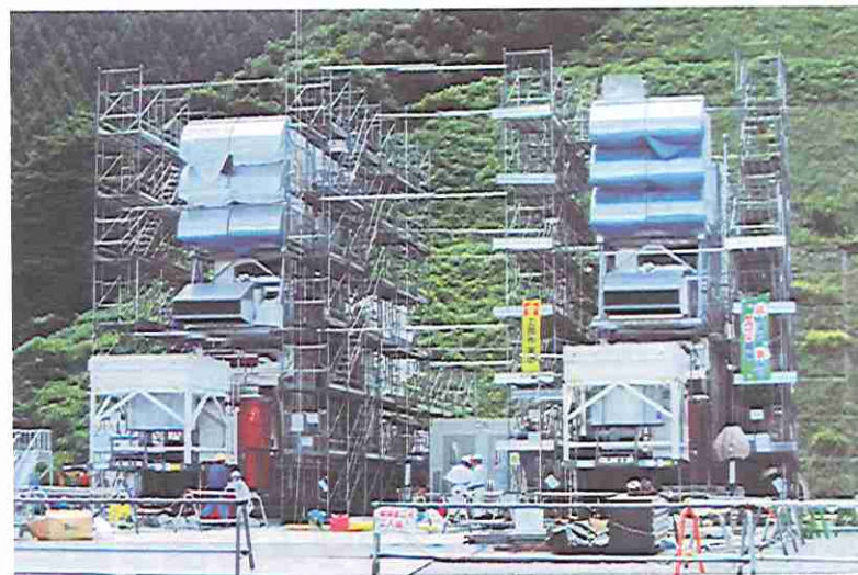
高台への設置工事の様子
