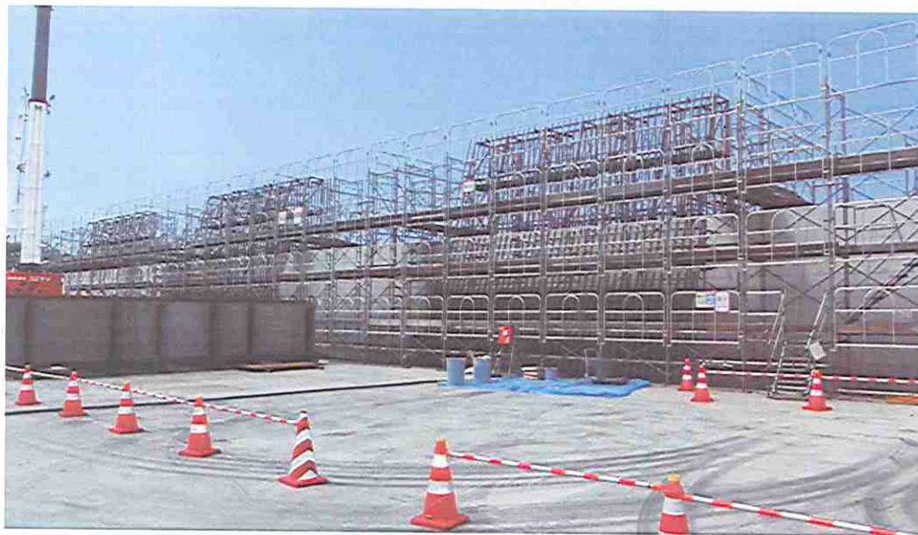
防波壁工事の状況
