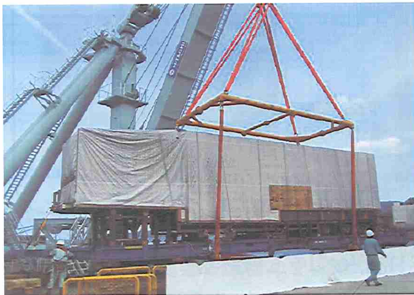
イギリスから輸送されたガスタービン発電機(4分割で納入)の荷揚げの様子
