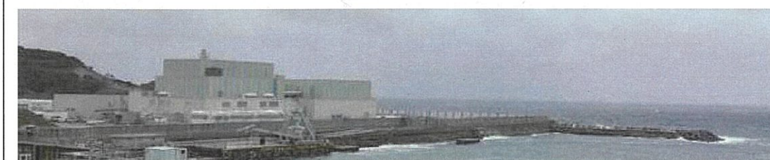
敷地東側からの全景
