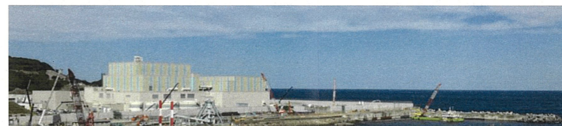
敷地東側からの全景
