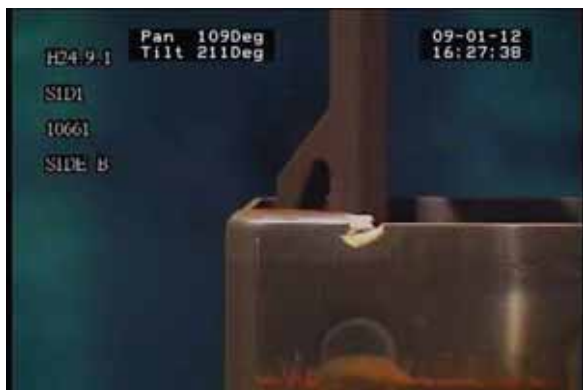
No. 1 10661 (神戸製鋼) 欠損部長さ 約11mm (B面)
