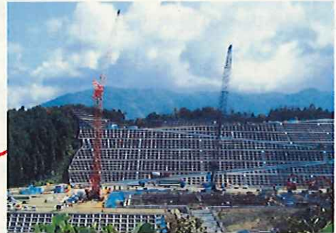
▲免震重要棟設置工事状況
