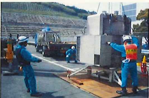
▲原子炉補機海水ポンプ電動機取替訓練
