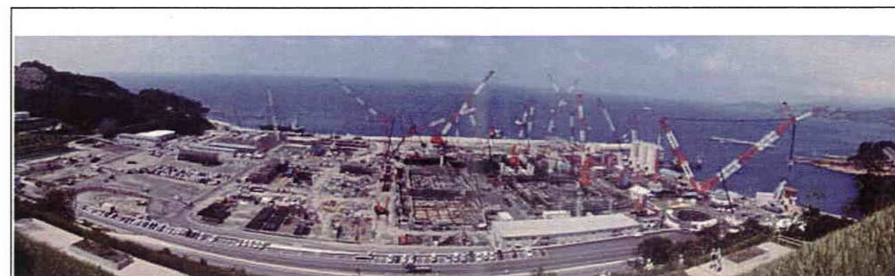
敷地南側からの全景
