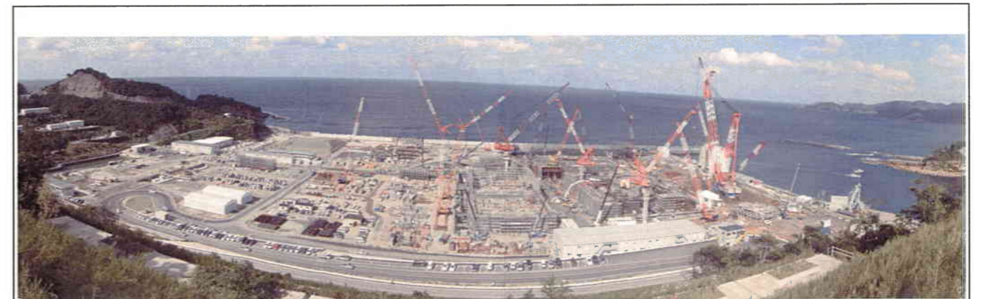
敷地南側からの全景
