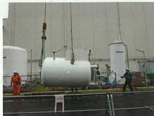
屋外設備の解体撤去
