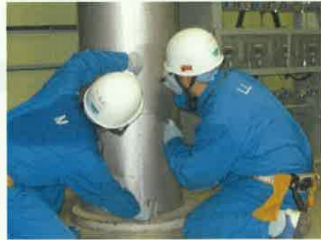
配管へのマーキング作業
