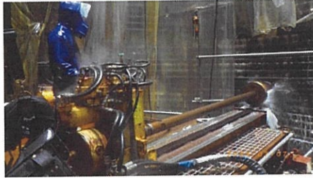
横方向に排水穴(最長150m)掘進
