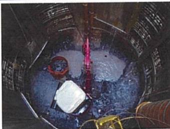
立坑掘削(地下32mまで)
