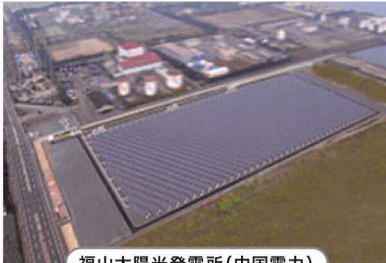
福山太陽光発電所(中国電力)
