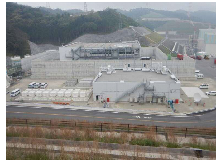
工事状況(平成30年4月23日撮影)
