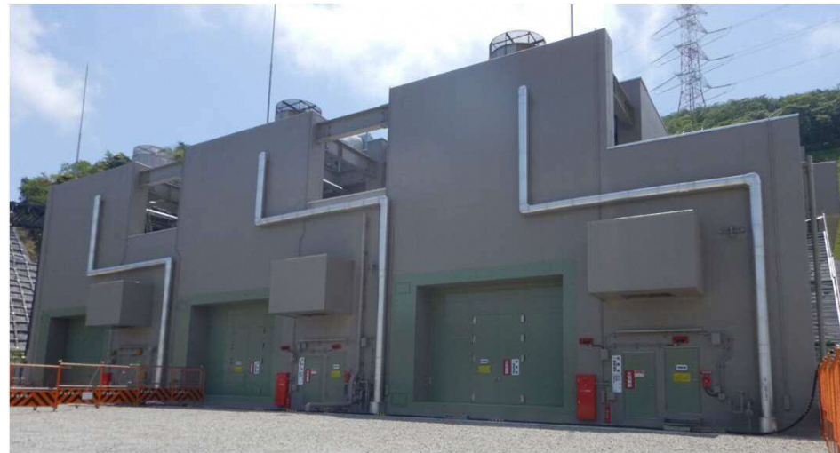
建物工事状況(平成30年5月14日撮影)
