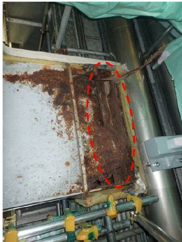
腐食孔 約 100cm×約 30cm
