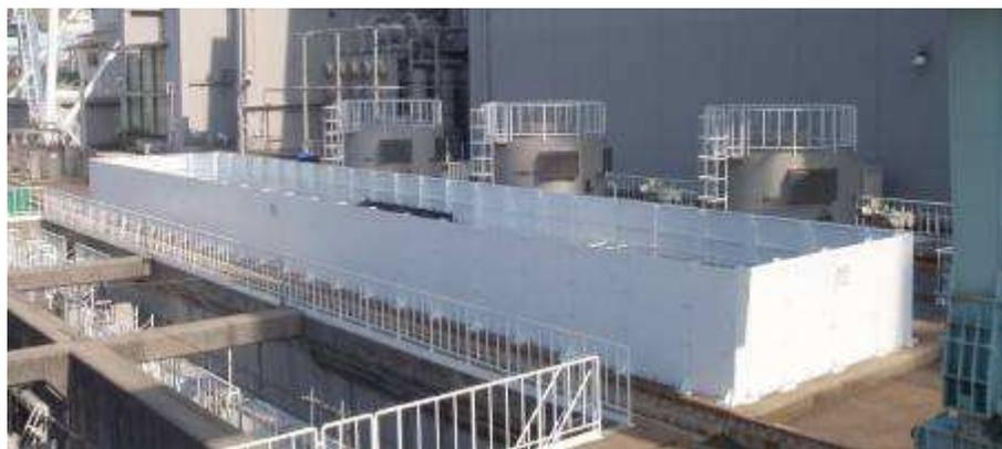
2号機原子炉補機海水ポンプエリアに設置した防水壁
