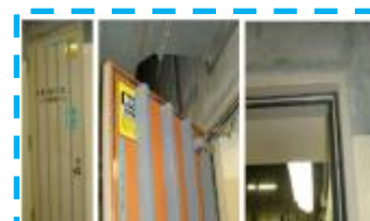
水密扉の例(四国電力HPより)
