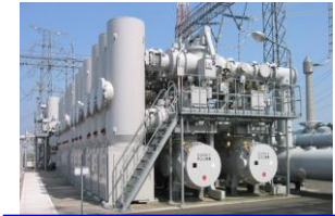
550kVガス絶縁開閉装置(GIS) (出典)㈱日本パワーシステムズ HP
