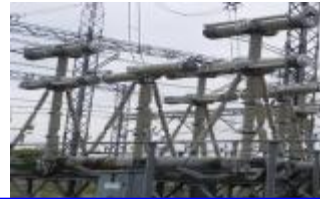
275kV空気遮断器(ABB) (出典)第1回電気設備地震対策WG資料
