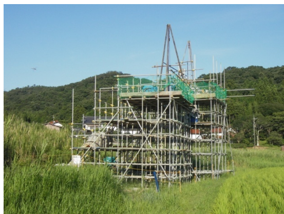
ボーリング調査状況
