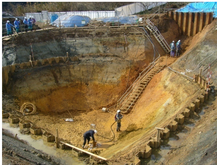
トレンチ調査状況
