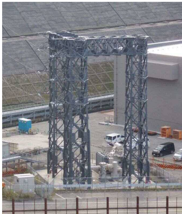
第2-66kV開閉所外観
