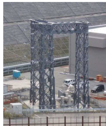
第2-66kV開閉所外観
