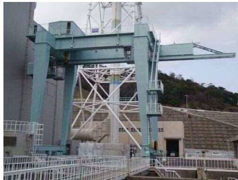
取水槽ガントリークレーンの外観（ダンパ設置前）
