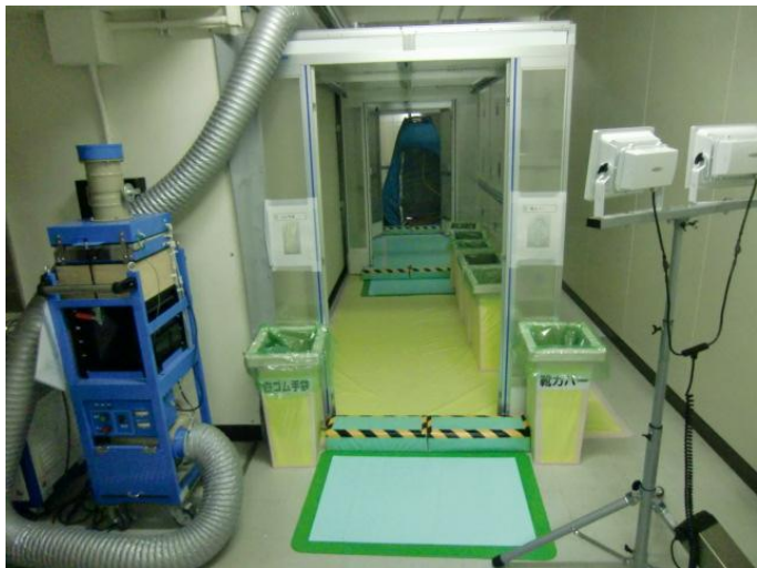
第6-3図 放管エリア設営写真
