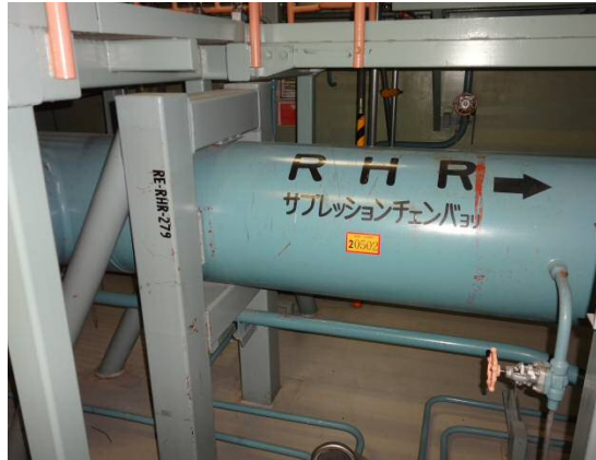
配管 & 支持構造物
