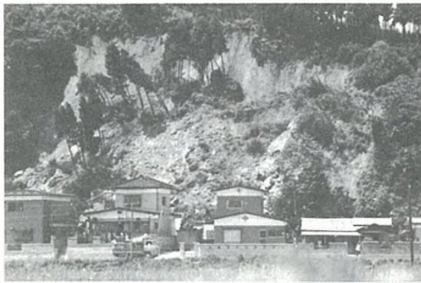
図 6.5-3 1978 年宮城県沖地震 松島町高山下地区がけ崩れ被災状況及び横断面図 (土木学会東北支部(1980) 13) )
