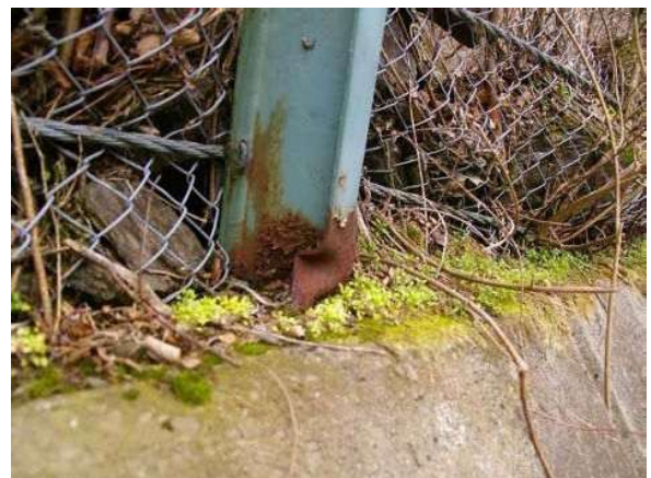
写真 2.29 支柱の錆び
