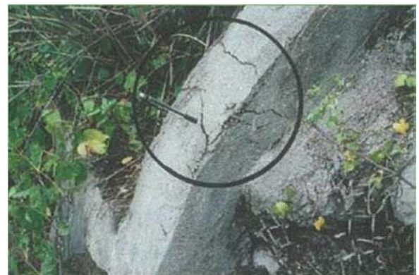
写真 2.14 法枠の割れ
