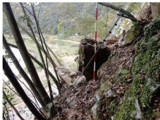
写真 2.10 法肩にある不安定な浮石
