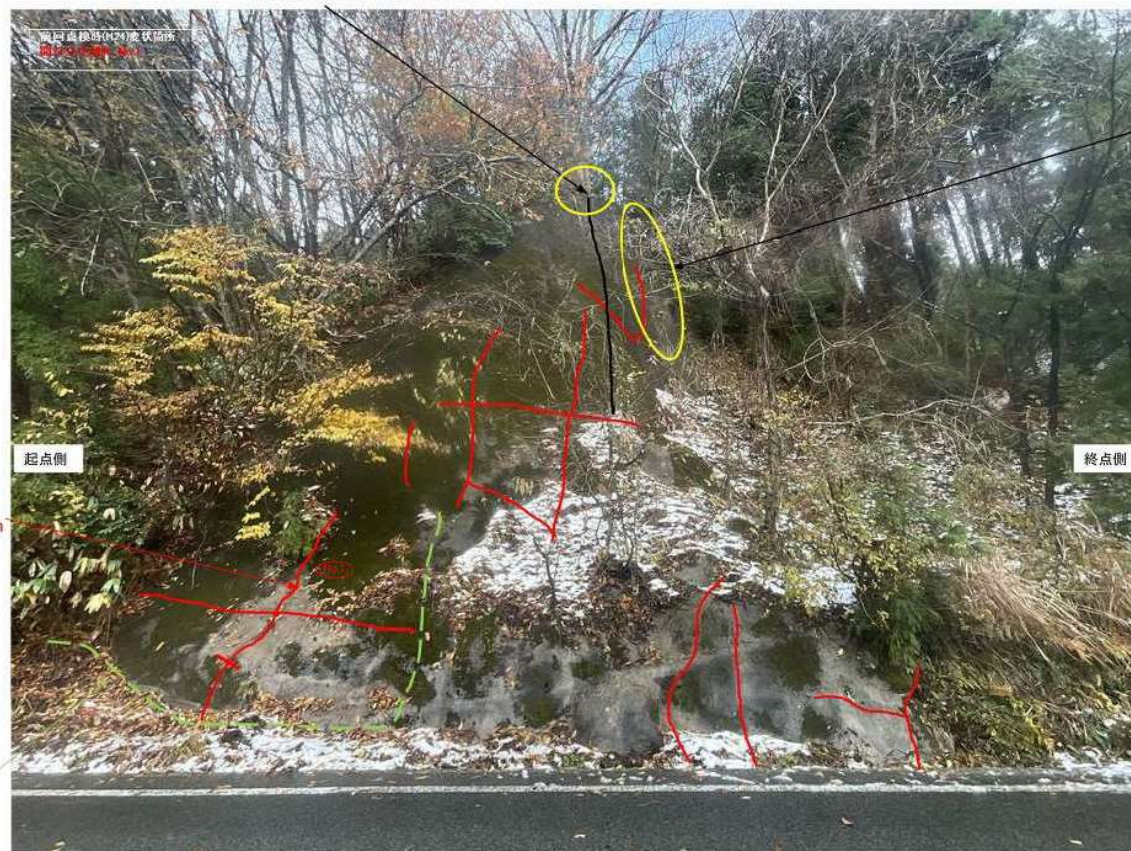
写真③ 亀裂(空洞化) 幅=40mm
