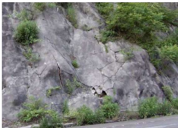
写真 2.4 ひび割れ(全体的・長い・幅大きい例)
