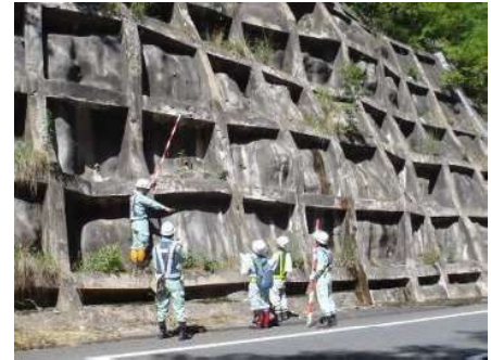
目合わせ点検の状況
