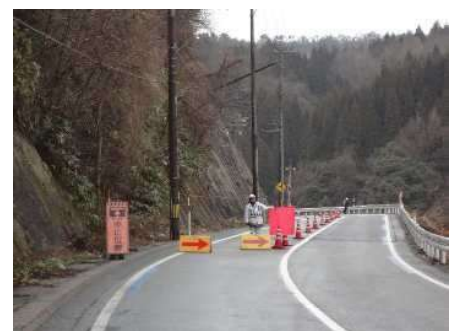
片側車線規制
