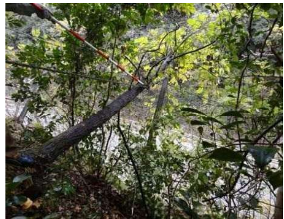
写真 2.17 倒木による支柱の傾倒
