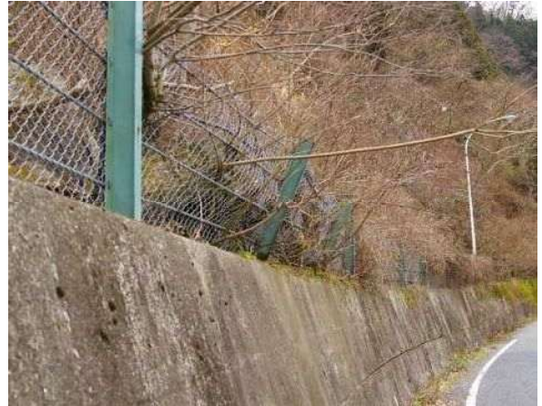
写真 2.27 支柱の倒れ
