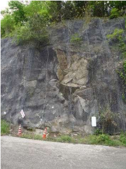
写真 2.19 ネット内の拘束
