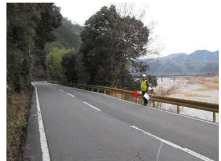
法尻に配置した見張り員
