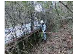
防護柵背面の状況
