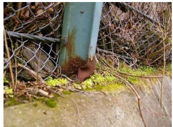
写真 2.29 支柱の錆び
