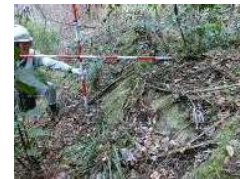
擁壁直上のモルタル吹付工
