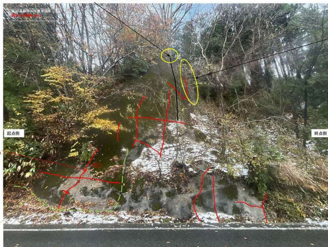
写真③ 亀裂(空洞化) 幅=40mm
