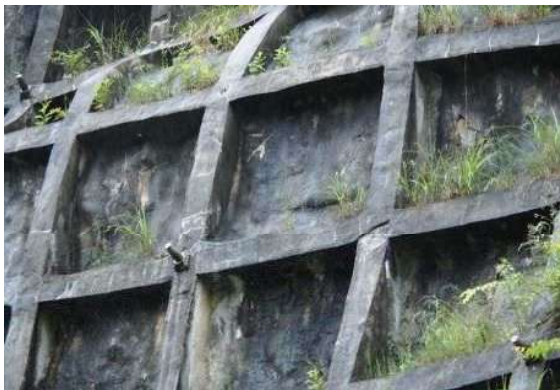
写真 2.13 法枠の割れ
