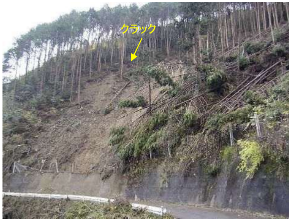
写真 2.8 崩壊斜面のクラック
