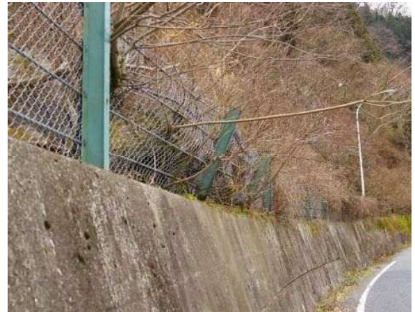
写真 2.27 支柱の倒れ
