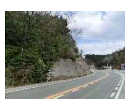
起点側からの全景
