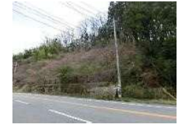
起点側からの全景
