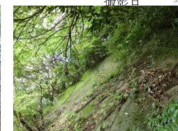
モルタル吹付工頭部の状況
