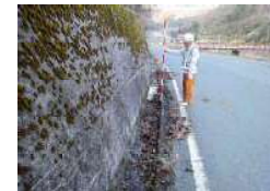
法尻(水路) 変状なし
