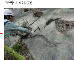
終点側モルタルのひび割れ
