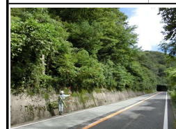
起点側からの全景
