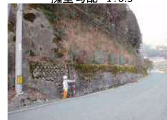
起点側からの全景
