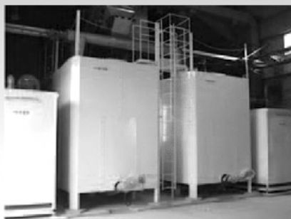
中央部(大)は発酵分解槽×2基 左右部(小)は生物脱臭槽×2基
