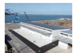
福井第2上屋 (令和4年11月供用)
