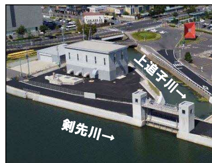
① 上道子排水機場(R3.9完成)
