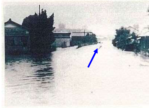
①出水状況(1964.7)
