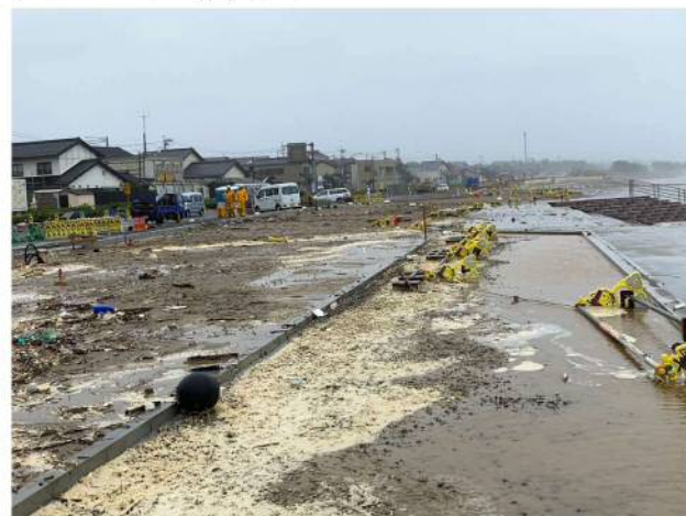
台風11号 被災状況
