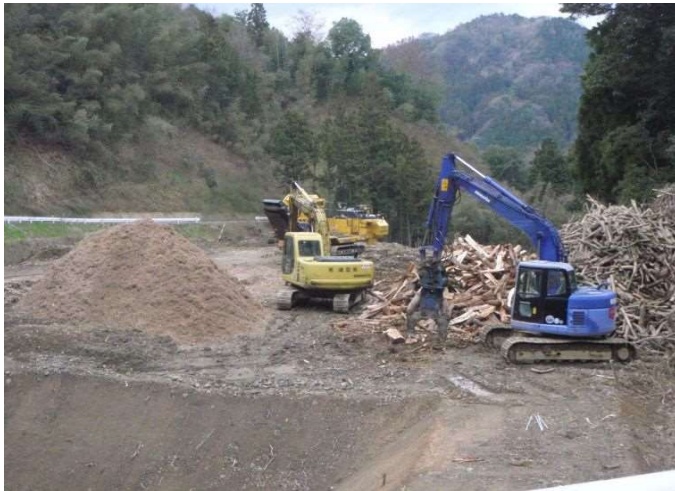
現場内のヤードにおいて伐採木等をチップ化
