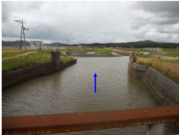
改修前(吉岡沢橋から下流)
