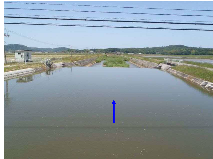
改修後(吉岡沢橋から下流)
