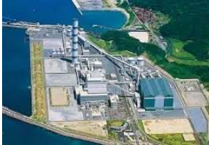
中国電力三隅火力発電所（石炭混焼）
