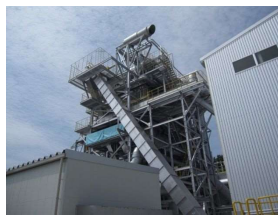
バイオマス発電所
