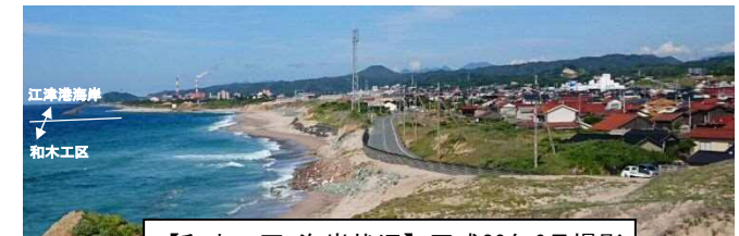
【和木工区 海岸状況】平成29年6月撮影
