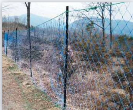
シカ防護柵の設置
