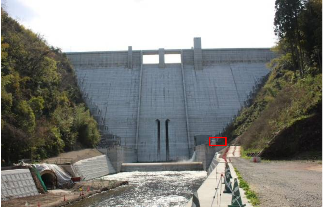
堤体下流より
