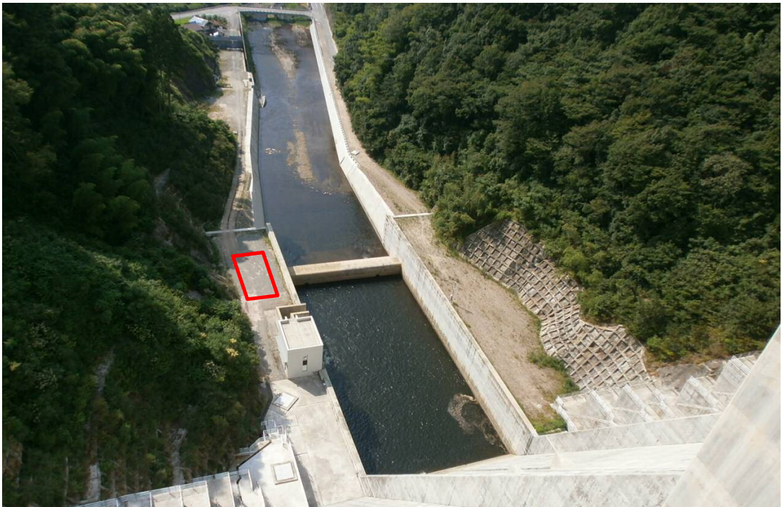
堤体上部より
